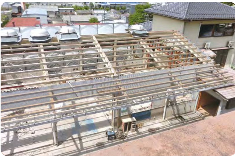
作業棟解体（屋根部分）
