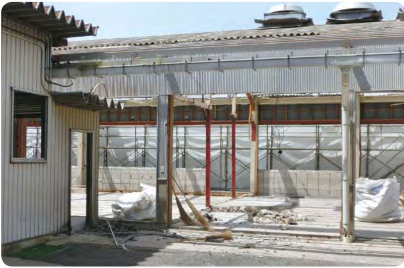
作業棟解体（入口付近）
